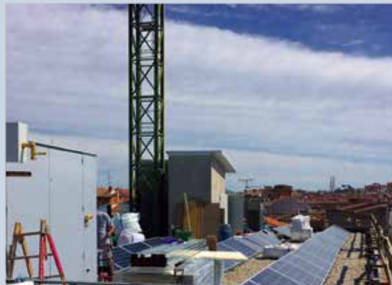
Imatge de la coberta de la residència on es fan els darrers acabats
