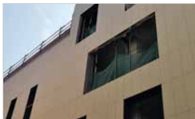
Detall de les obres d'ampliació del centre
