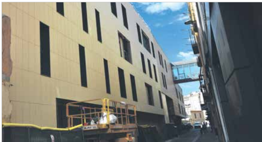
L'edifici annex a l'actual residència ja és ben visible i es continua treballant al carrer Remei de Dalt
